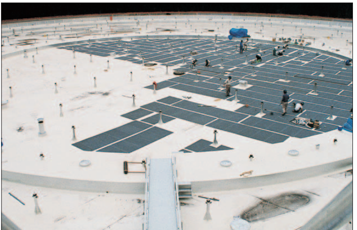
石油タンク屋上断熱材
