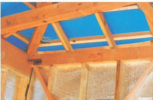
屋根裏断熱施工
