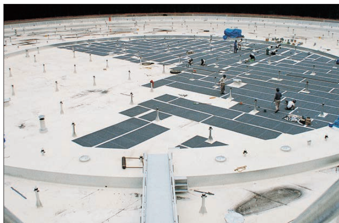
石油タンク屋上断熱材
