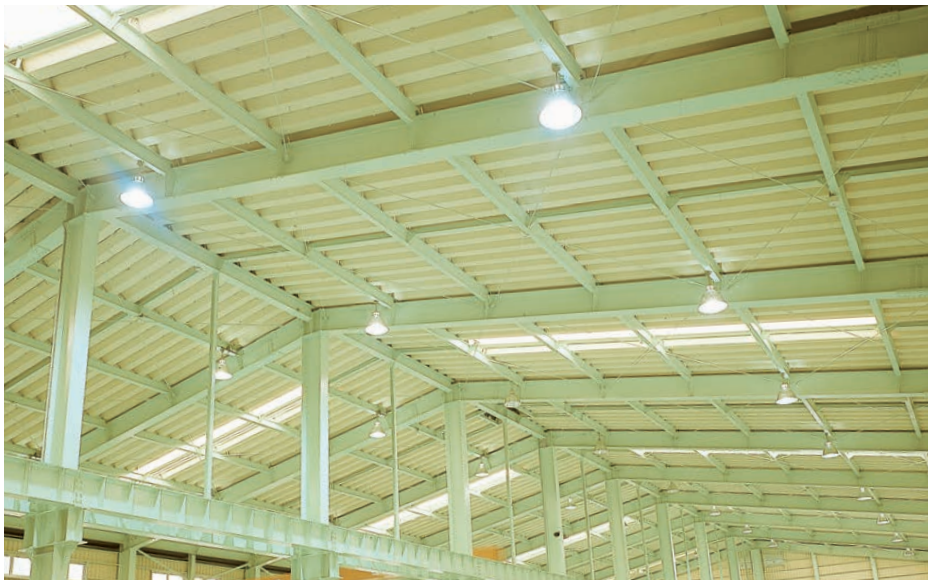
折板構造長尺屋根の裏貼り断熱材
