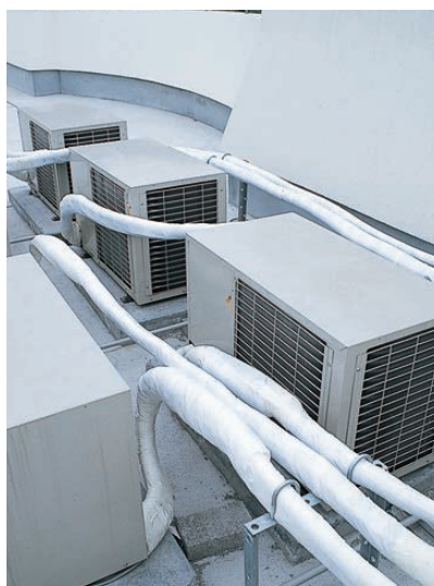
業務用エアコン断熱配管
