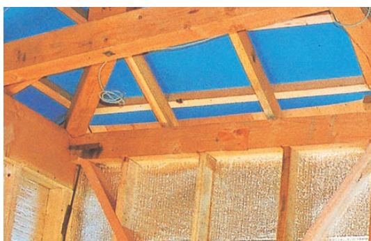
屋根裏断熱施工
